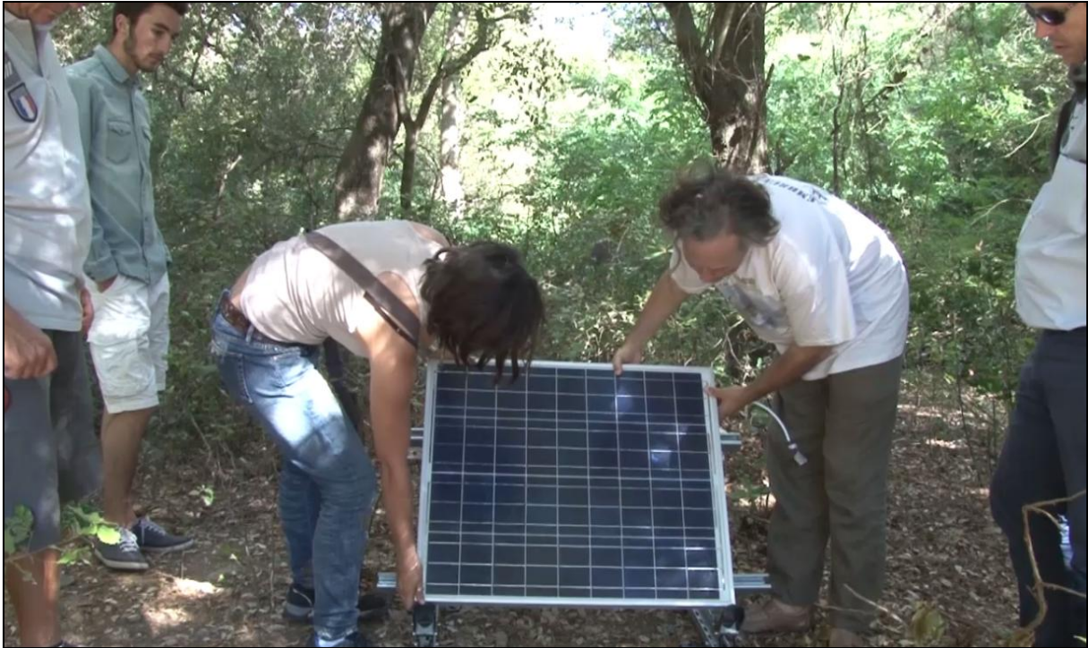
Figure 6 : Mise en place d'un panneau solaire sur le terrain. L'équipe est en train de fixer le panneau à sa structure.
