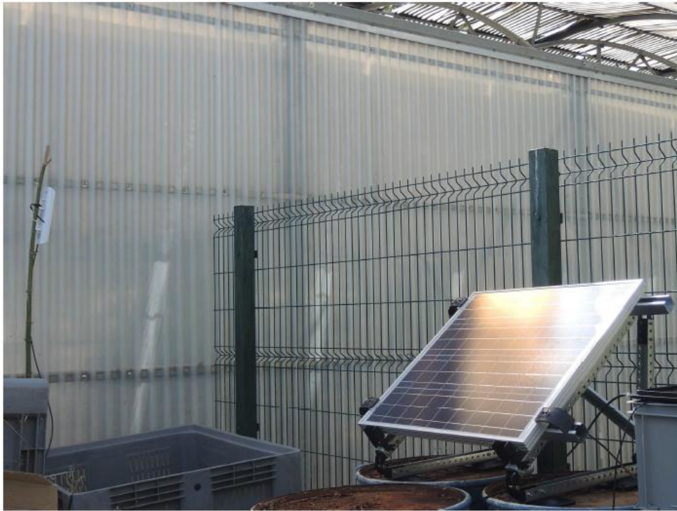
Figure n°1 : mise en place du panneau solaire et de l'antenne wifi en extérieur sur le campus de l'UTLN.
