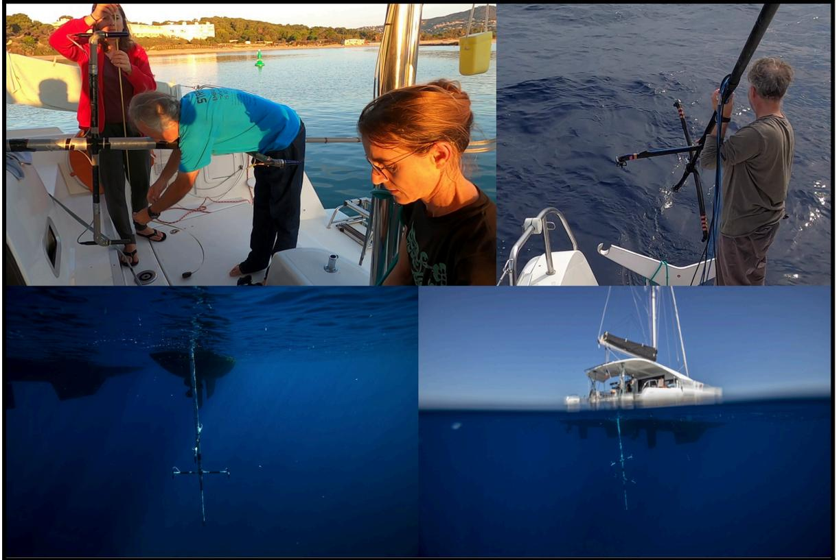
Figure 3.4 : (Haut Gauche) Installation de l'antenne Baguera. (Haut Droit) Mise à l'eau de l'antenne. (Bas) Vues sous-marines de l'antenne en place (crédit F. Sarano / Longitude 181 / S. Chavin).
